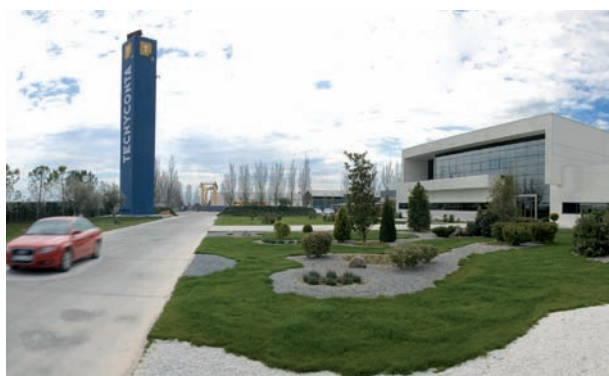
Oficinas centrales en Tauste. Zaragoza.
