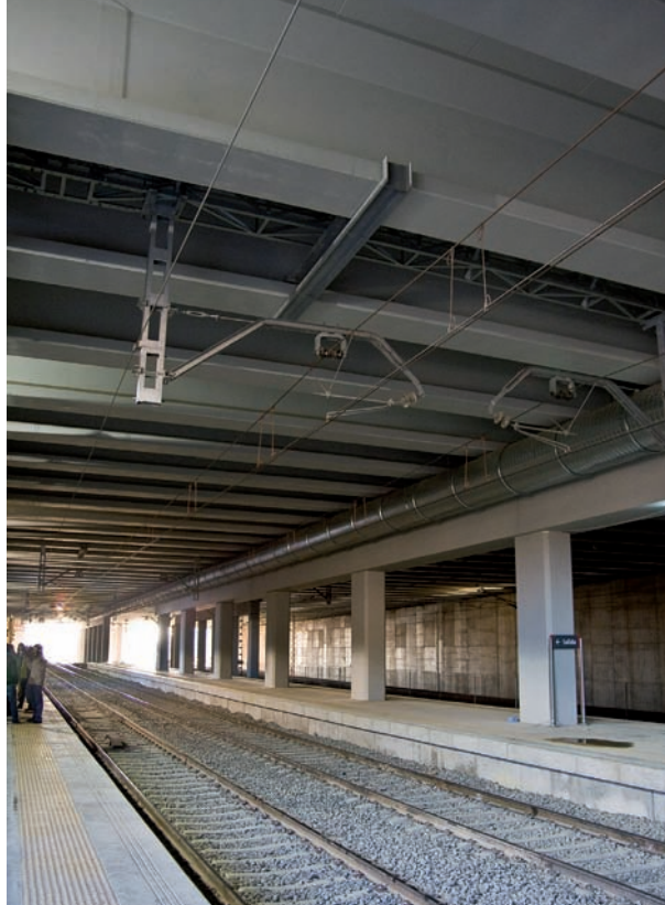
Estación Miraflores. Zaragoza.
